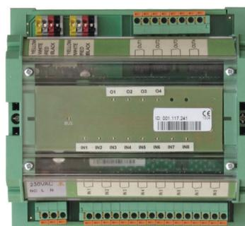
Das Feldmodul ZENIX DI8DO4 verfügt über 8 potentialfreie digitale Eingänge und 4 digitale Relaisausgänge. Es kann z.B. für den Anschluss zusätzlicher Alarmeingänge der Brandmeldeanlage (Matrix) verwendet werden. Die Relaisausgänge können programmiert sowie Sicherheitsmodi definiert werden.
